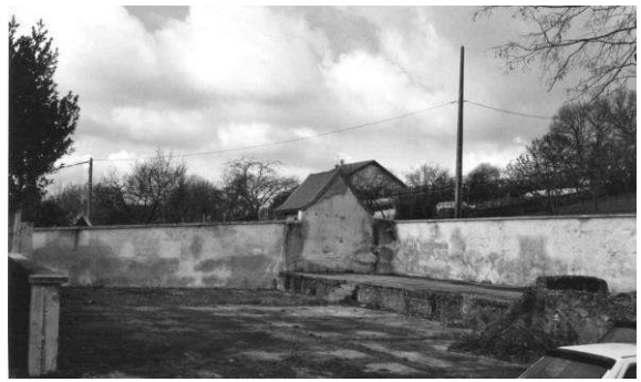
En 2004, voici ce qu'il reste des deux niveaux de l'usine
